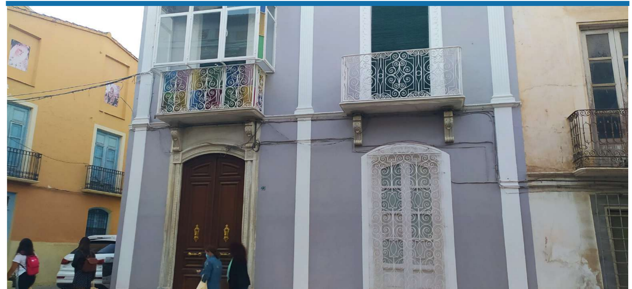
Una de las fachadas recientemente rehabilitada, la Casa de los Toledo o de Felipe II en la calle del Pilar
